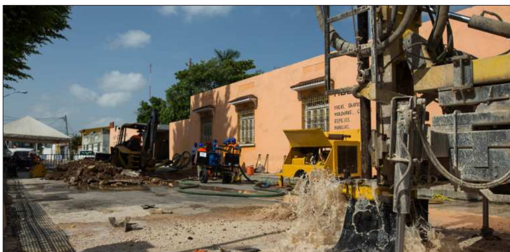
▲ Las deficiencias de la paraestatal eran de sobra conocidas, particularmente la obsolescencia de su red de distribución, así como la falta de coordinación entre autoridades. Foto Enrique Osorno / Archivo
