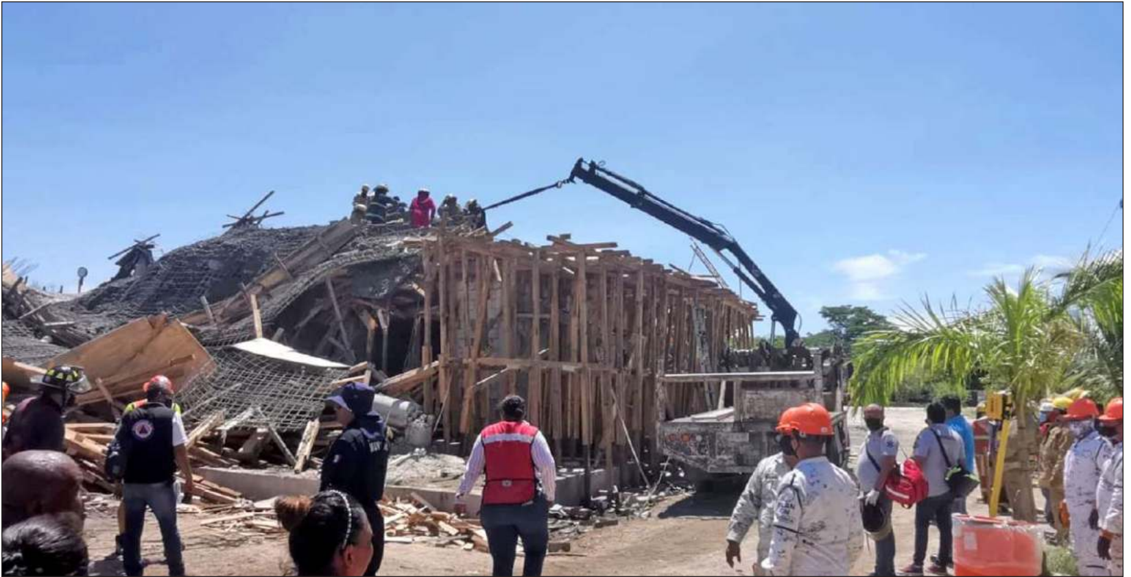
▲ El dictamen de la Fiscalía General de la República concluye que el polideportivo de la colonia Renovación no fue construido como indicaba la memoria de cálculo, en conjunto con los planos arquitectónicos, además de que se emplearon materiales de menor calidad. Foto Gabriel Graniel
