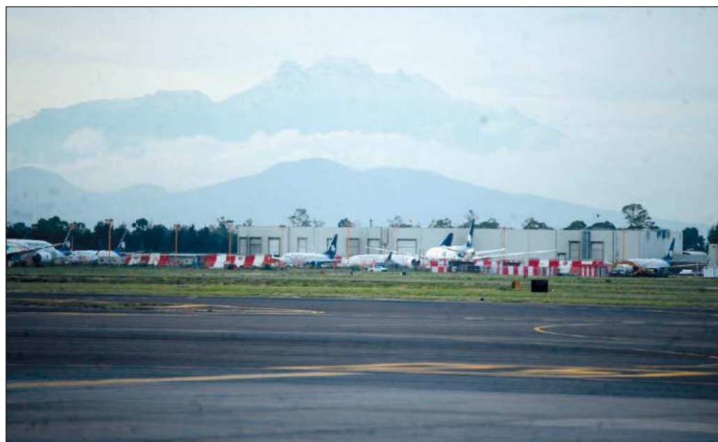
▲ De resultar cierta la existencia de fallas estructurales en la terminal 2 del aeropuerto Benito Juárez, será pertinente investigar cómo se ejecutaron las obras. Foto Cristina Rodríguez
