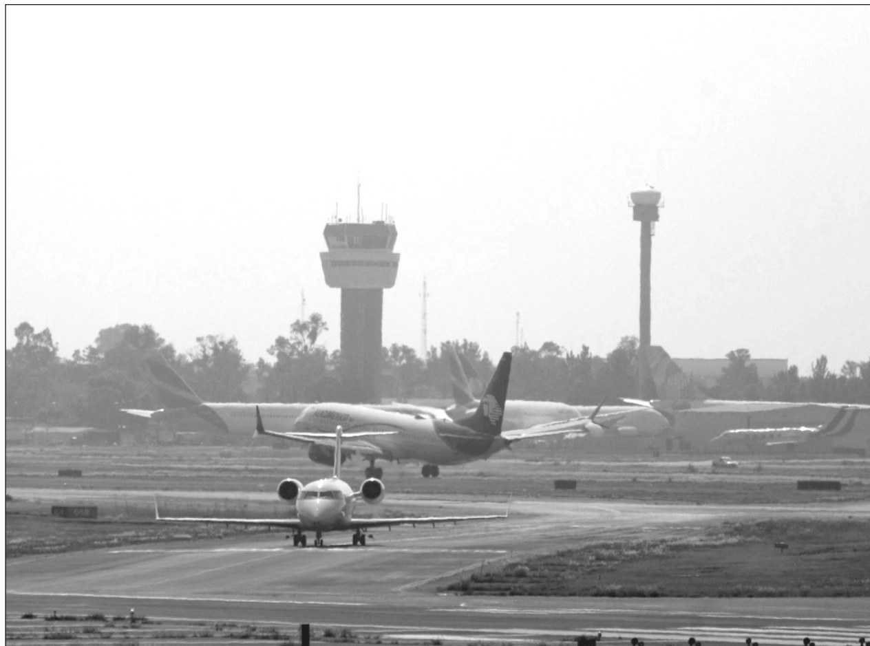
▲ Las obras en la pista 05L/23R incluyen la reposición de carpeta asfáltica según se requiera. Foto Alfredo Domínguez
