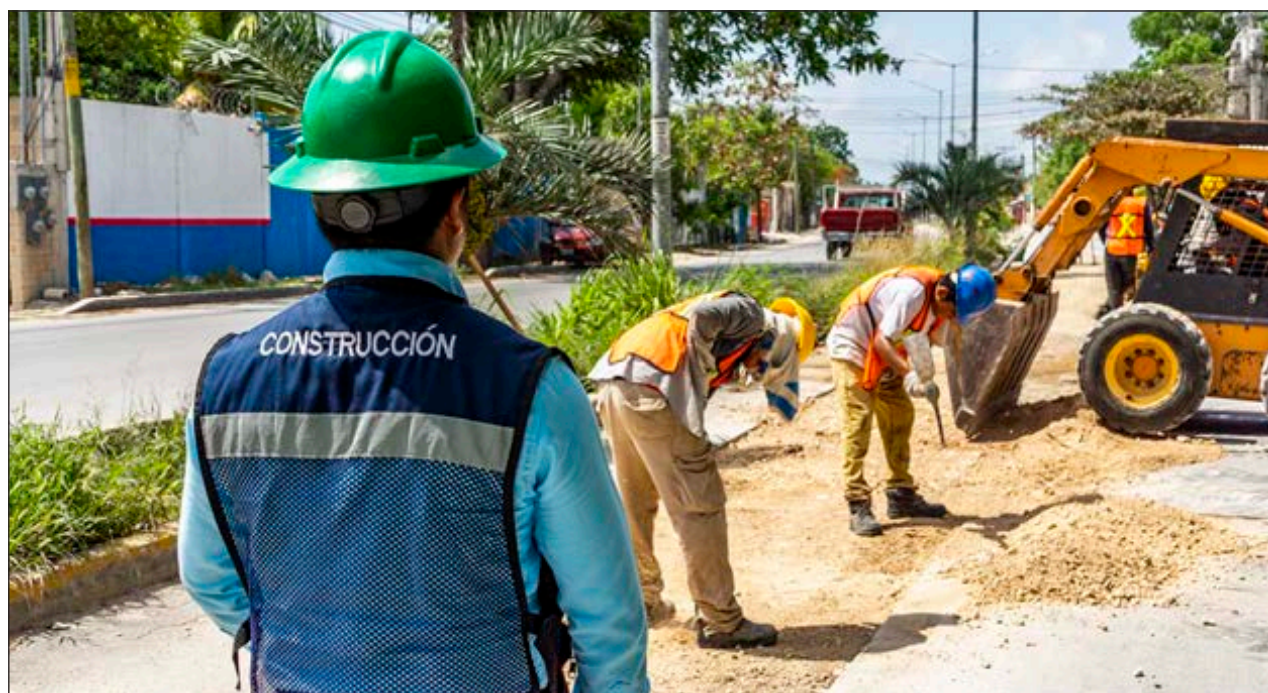
▲ Aguakan pretende terminar al 100% las obras a inicios del 2021, para dar paso a nuevas inversiones. Foto Aguakan
