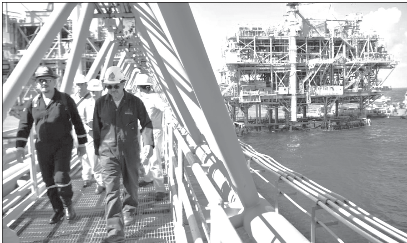
▲ Los trabajadores de la petrolera revelaron que el accidente se registró alrededor de las 18:45 horas, en el área de separadores del Centro de Proceso Abkatun N1, sin que se tuvieran reportes de obreros lesionados. Foto Twitter @Pemex
