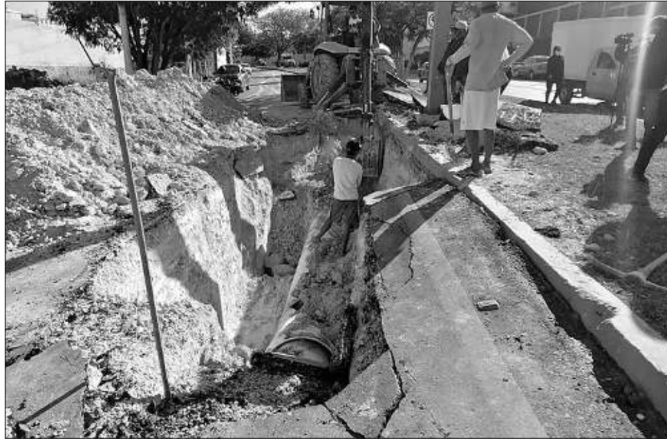
▲ En lo que va del año, van 10 veces que se reporta una fuga de agua junto con daños a la infraestructura vial de la capital campechana, según el director del SMAPAC. Foto Fernando Eloy
