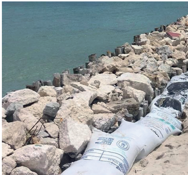
▲ Los espolones, conocidos también como espigones, son estructuras colocadas transversalmente a la línea de costa, que han sido usadas históricamente para proteger y recuperar zonas de costa. Foto Facebook Abreu Rosado
