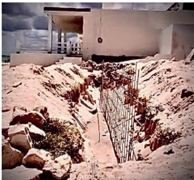
▲ Los espolones, conocidos también como espigones, son estructuras colocadas transversalmente a la línea de costa, que han sido usadas históricamente para proteger y recuperar zonas de costa. Foto Facebook Abreu Rosado
