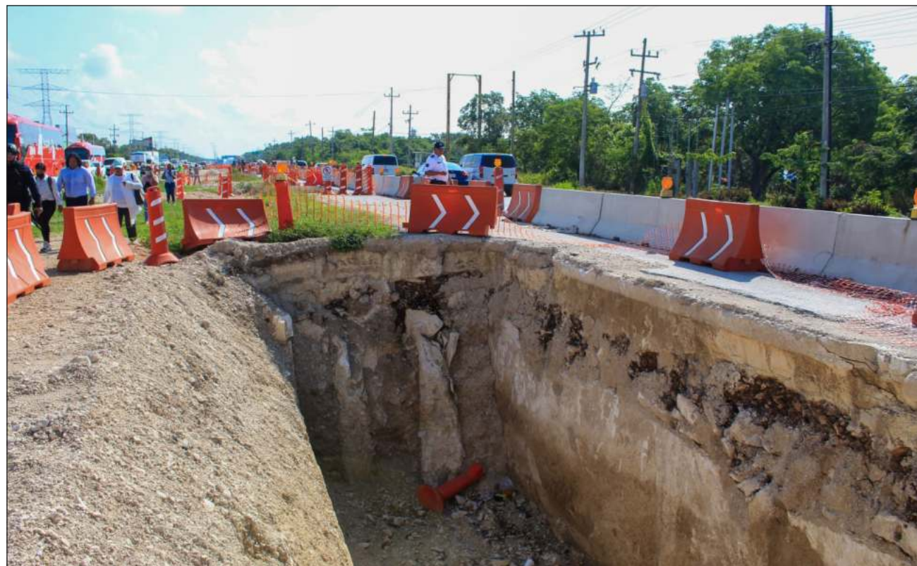
▲ Los trabajos también incluyen la reparación de un socavón en el kilómetro 265, obras de drenaje, señalización y bacheo. Foto Rosario Ruiz
