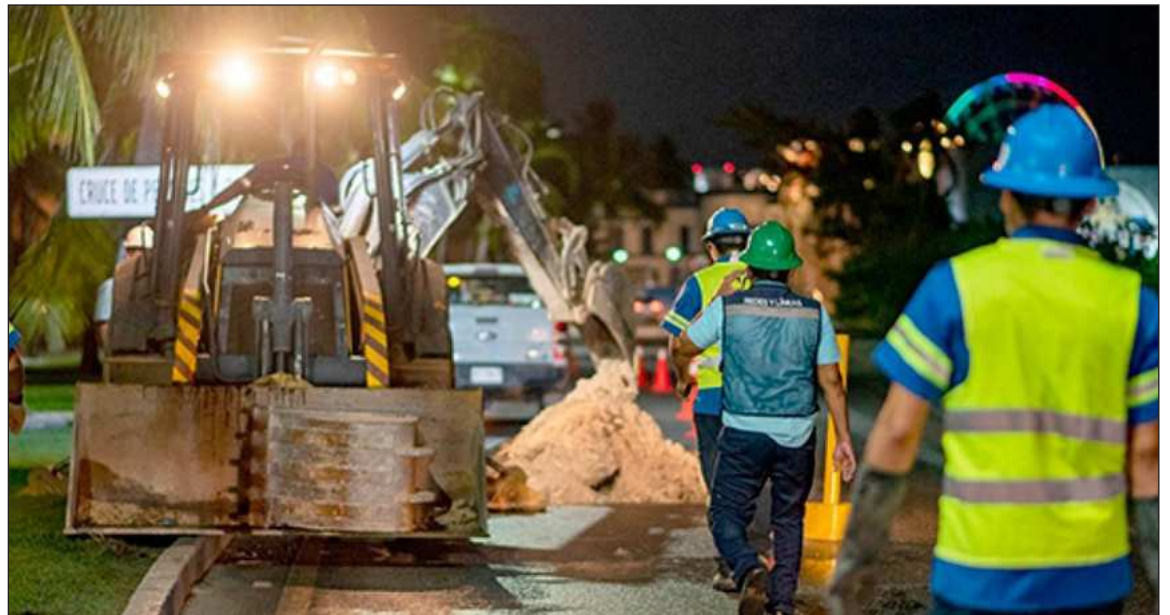
▲ El periodo total de obra comprende de octubre 2025 a septiembre 2026 y se ha dividido en cuatro tramos, cada uno con un tiempo estimado de ejecución de 45 días, con el objetivo de mantener un proceso ordenado. Foto Aguakan
