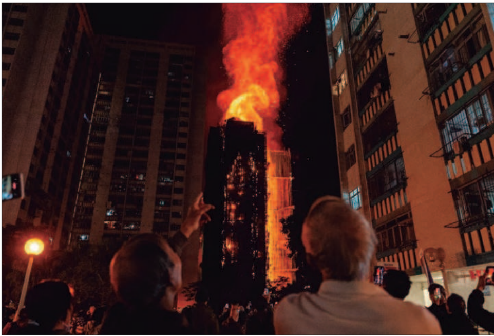
▲ El complejo de viviendas Wang Fuk Court alberga casi 2 mil departamentos los cuales eran habitado por unas 4 mil 800 personas, incluidas muchos adultos mayores. Foto crédito
