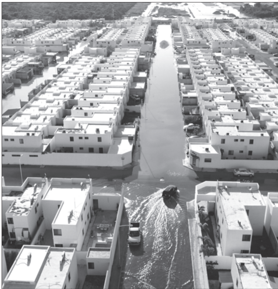
▲ En varias zonas de Mérida se realizaron trabajos de desazolve de pozos y limpieza de rejillas, para prevenir mayores inundaciones. Foto DeAquiSoy.mx
