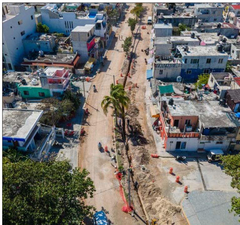
Inició la renovación de la red de agua potable sobre la Avenida Rueda Medina, en el tramo que va desde Ultramar Carga hasta la calle 2 de abril. Foto Aguakan
