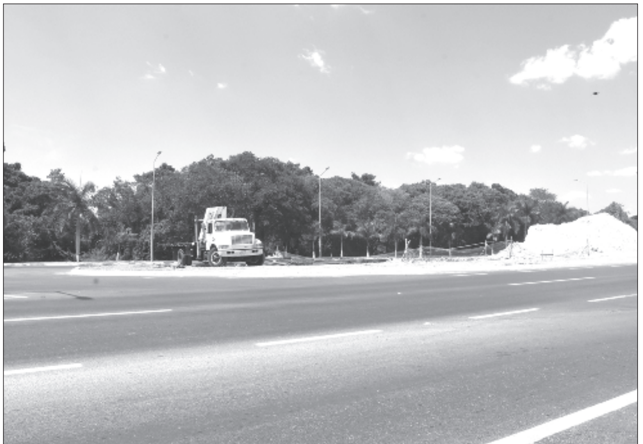
▲ De acuerdo con la Secretaría de Infraestructura se tienen proyecciones de lineamientos en Champotón, Escárcega y Carmen, así como la ampliación de carreteras como la 180, donde hay tramos que son de dos carriles. Foto Fernando Eloy
