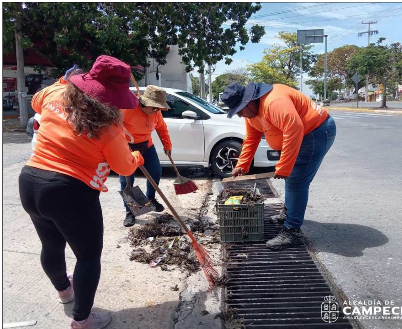
▲ Los trabajos tiene el objetivo de mitigar los riesgos de inundación en zonas urbanas vulnerables. Foto ayuntamiento de Campeche
