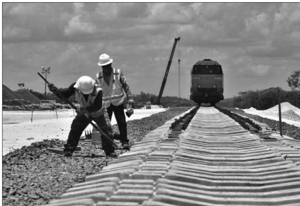
▲ El presidente López Obrador anunció que a partir de enero intensificará sus giras de supervisión del Tren Maya, dado que el proyecto enfrenta problemas como escasez de mano de obra o falta de disposición de carros de volteo. Foto Fonatur
