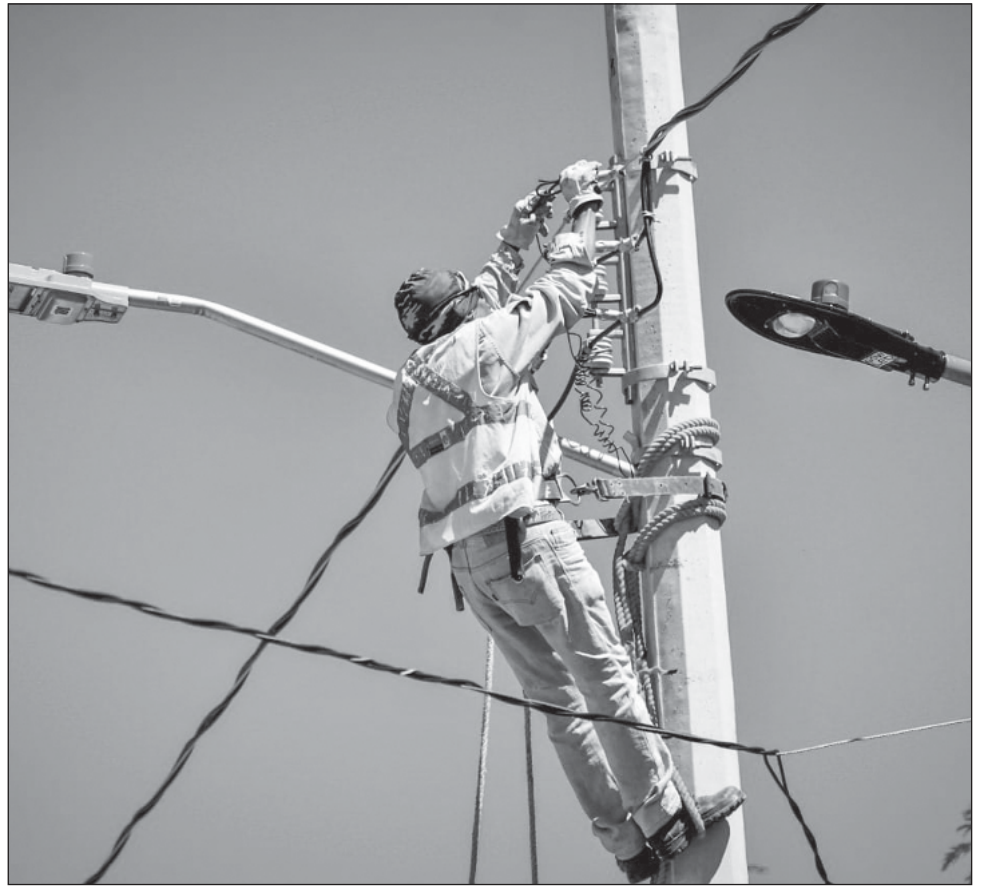
▲ De acuerdo con el director de obras públicas, José Luis Llovera Abreu, se instalaron 31 postes, más 25 luminarias tipo Led, además de mil 792 metros lineales de conductor de aluminio. Foto Facebook Biby Rabelo
