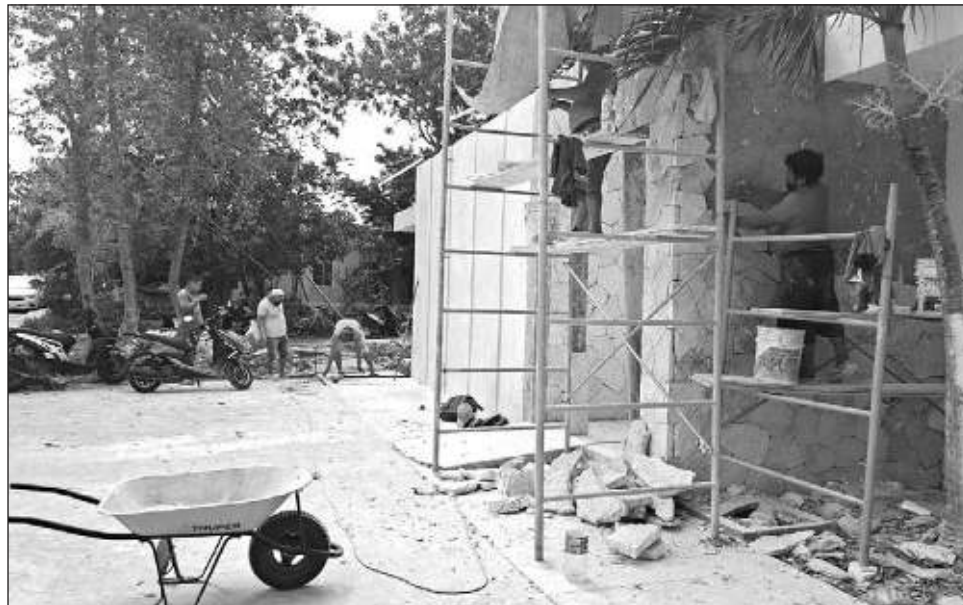
▲ Los recientes dos meses las condiciones climatológicas han frenado el desarrollo de las obras, entre las que destaca la rehabilitación de la avenida La Selva, remodelación de la avenida Cobá y la primera etapa del nuevo Centro de Comando, Control, Comunicación y Cómputo. Foto Miguel Améndola
