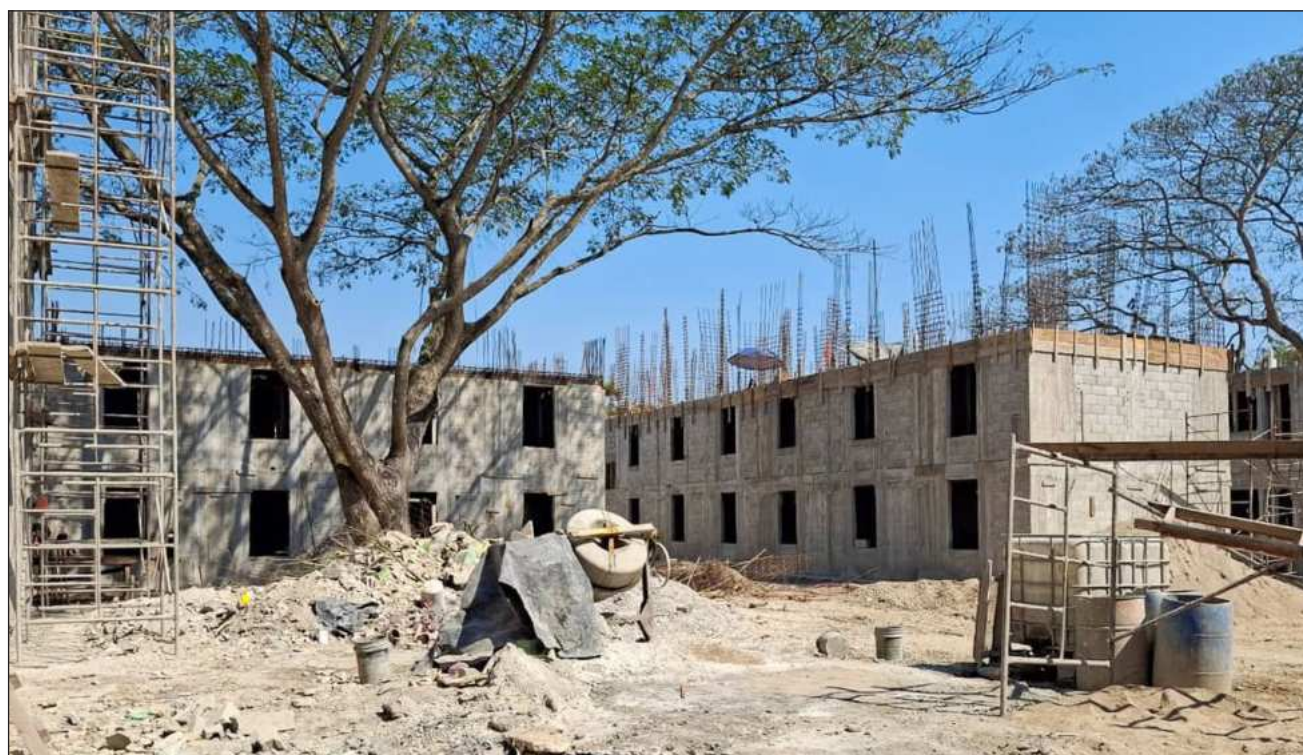
▲ Hasta ahora se tiene un avance de 24 por ciento, lo que significa que 20 mil ya están prácticamente construidas. Foto Conavi
