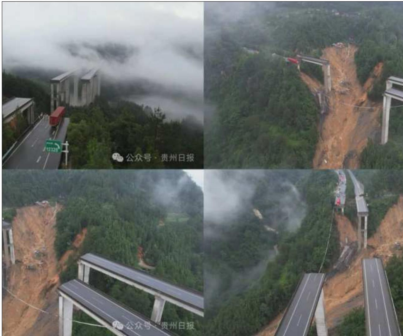
▲ Un deslizamiento de tierra provocado por las fuertes lluvias causó el derrumbe de los pilares del viaducto de la autopista de alta velocidad Xiazong; el conductor de un camión logró detener el vehículo a tiempo, colgado de su remolque al borde del precipicio. Foto Sputnik
