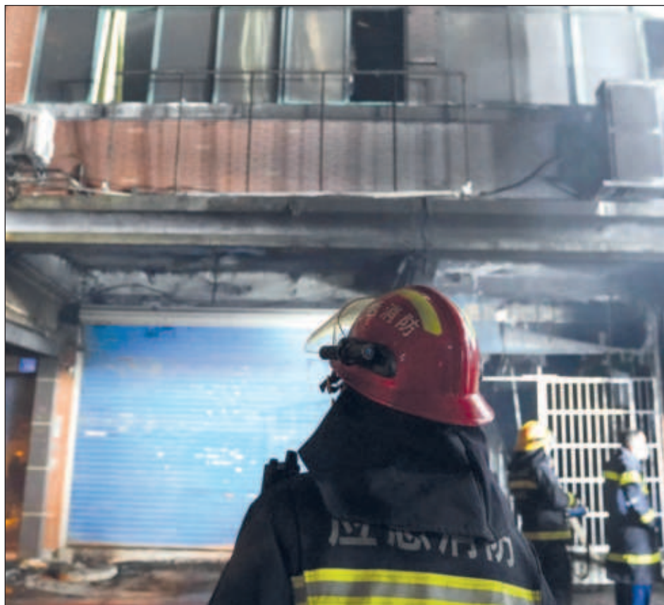
▲ De acuerdo con autoridades del distrito de Yushui, en la provincia de Jiangxi, el incendio comenzó en el interior de un área comercial a las 15:24 horas del miércoles. Foto Ap
