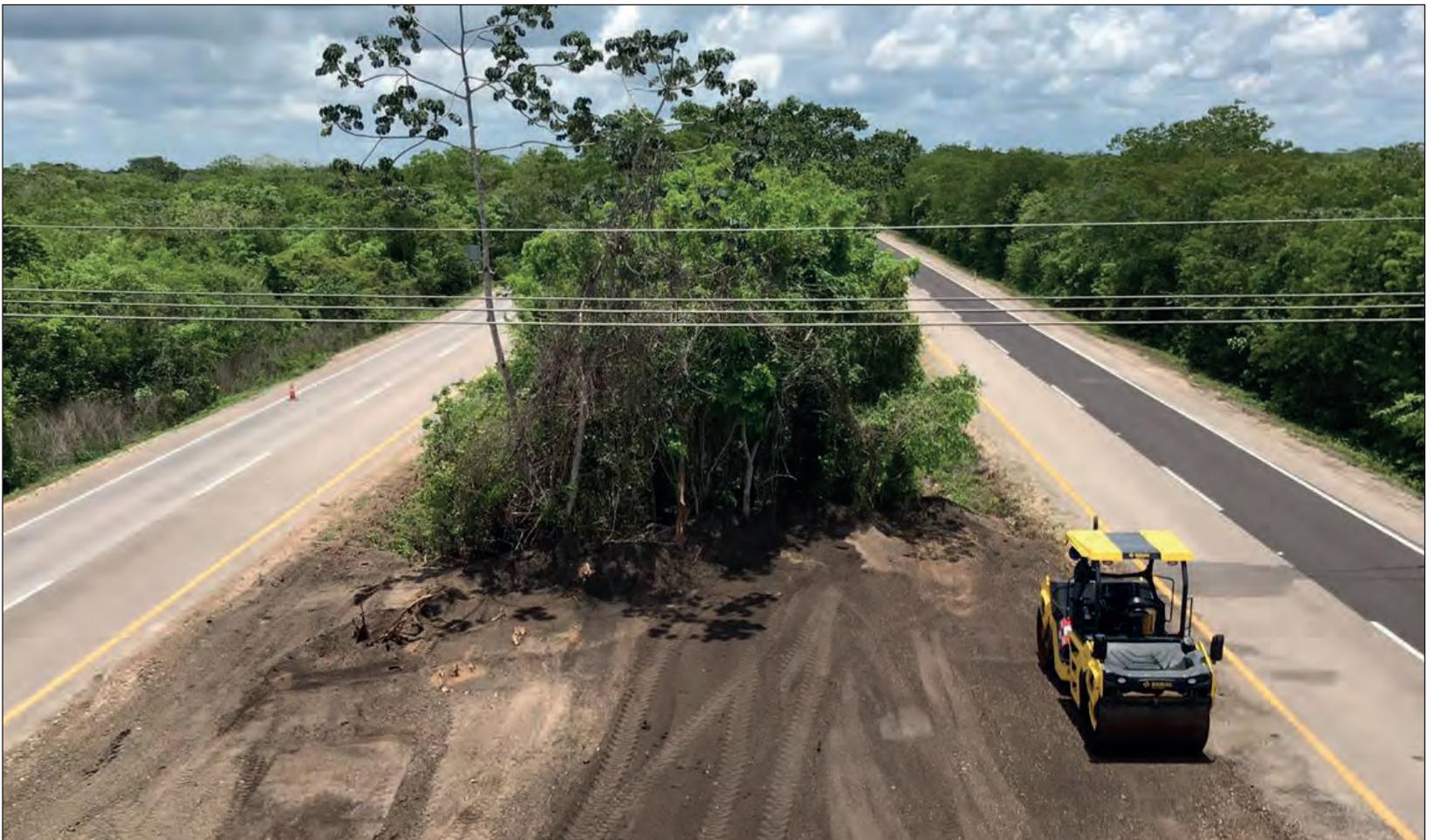
▲ El proceso de ampliación contempla el desmonte o retiro del material vegetal, el despalle y la excavación. Foto Fonatur
