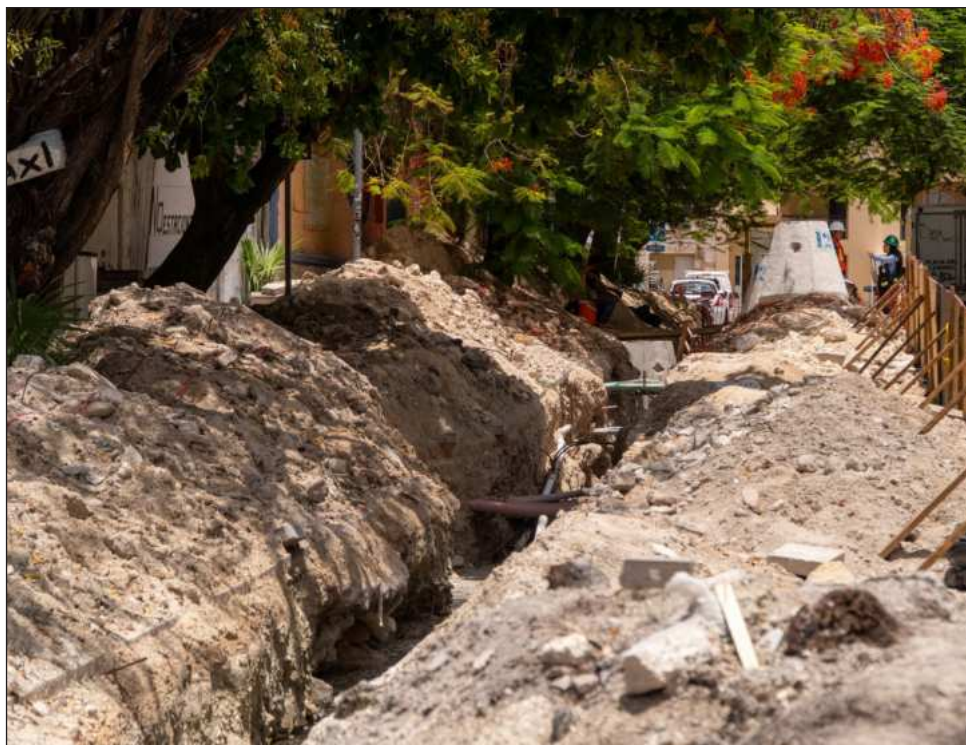
▲ Amplian alcance inicialmente previsto con la incorporación de 147 metros lineales de tubería sanitaria de 10 pulgadas. Foto Aguakan
