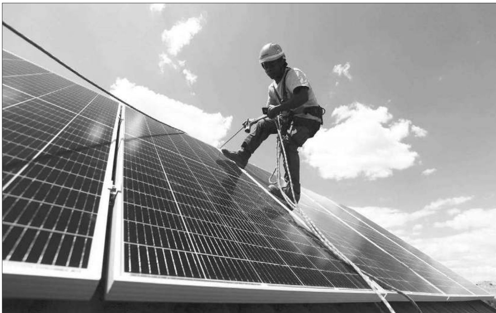
▲ "Mérida, en su calidad de principal consumidor de energía, debería utilizar todos los techos públicos y privados para instalar paneles solares y no estar cometiendo arbocidios para poner techos de acrílico con paneles como se está haciendo en el aeropuerto de la ciudad". Foto Reuters
