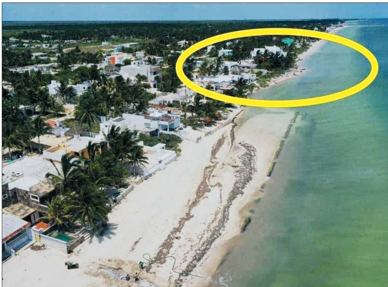
▲ En menos de dos meses se destruyó más de kilómetro y medio de playa; ahora el agua "se come" las casas, ya que no hay arena, sólo piedras. Foto cortesía vecinos de Telchac Puerto
