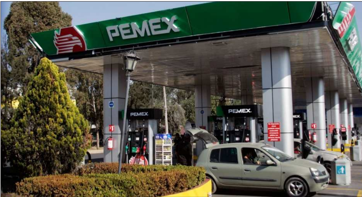
▲ La petrolera del Estado señaló en un comunicado que “mantiene una vigilancia constante para asegurar la integridad física de todas las instalaciones, así como de las y los trabajadores de Pemex”. Foto Roberto García
