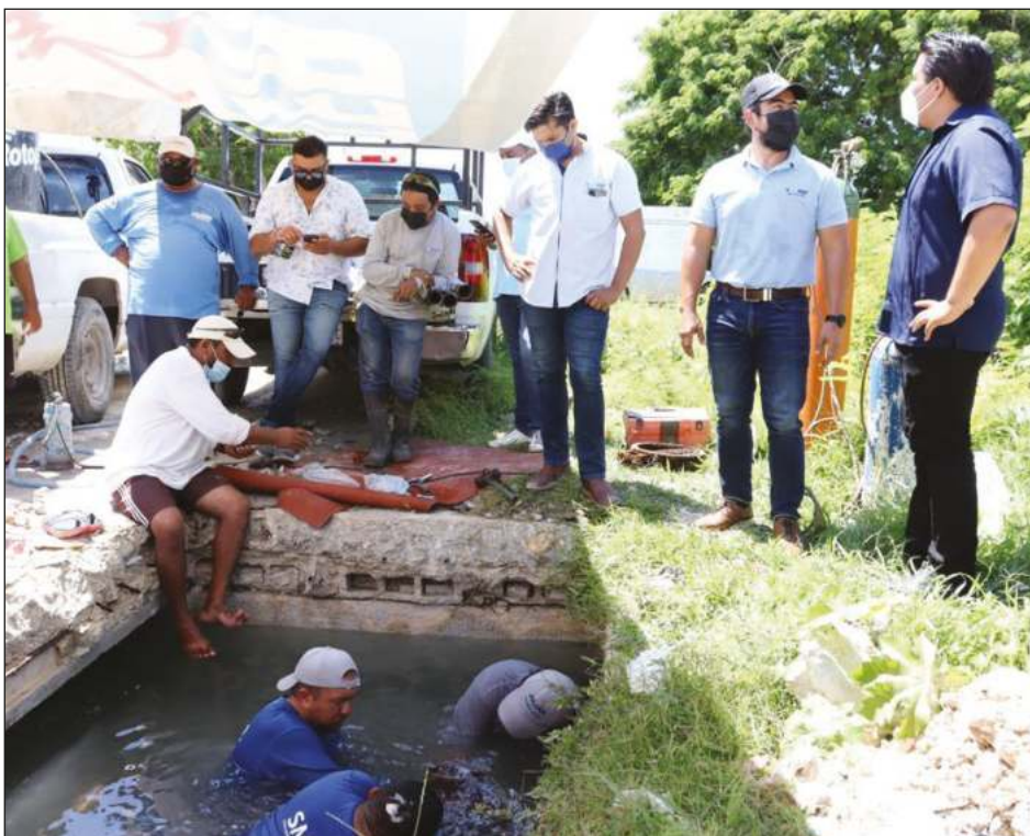
▲ Este miércoles, el presidente municipal Julián Zacarías Curi supervisó los trabajos de mejoramiento del cárcamo de Chuburná. Foto ayuntamiento de Progreso
