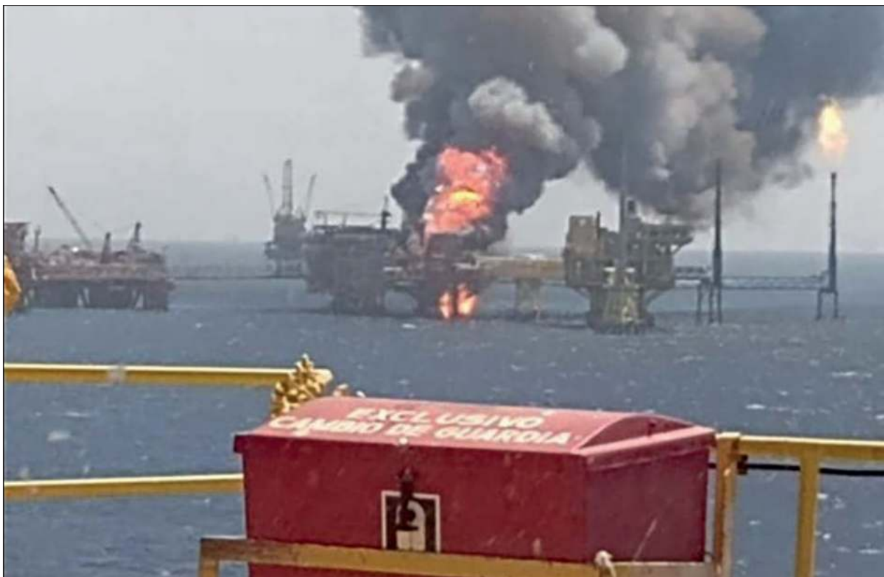
▲ Seis personas resultaron lesionadas con quemaduras de primero y tercer grados, así como contusiones, tras una explosión ocurrida la tarde de este domingo en la plataforma E Ku A2, de, del Centro de Procesos Ku Alfa, en la sonda de Campeche. Foto Lorenzo Chim
