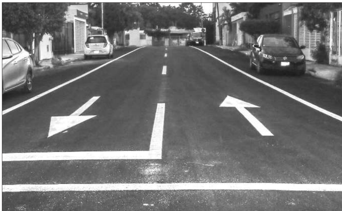
▲ Cecilia Patrón visitó el área intervenida en la calle 14 por 25 y avenida Quetzalcóatl, con 880 metros lineales. Foto ayuntamiento de Mérida
