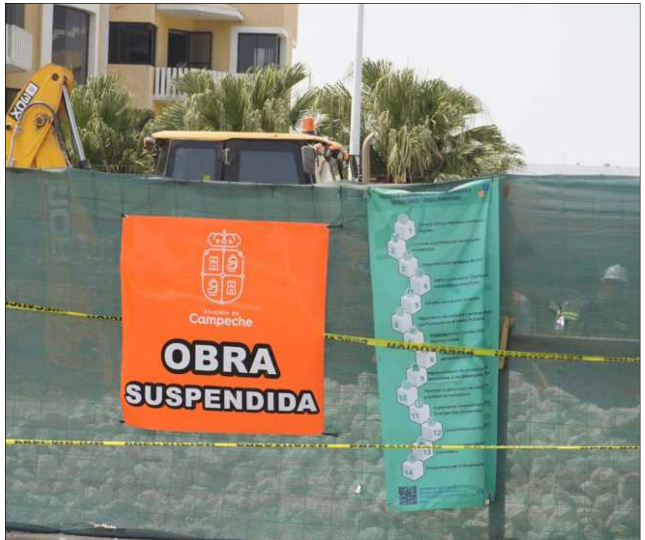
▲ La gobernadora añadió que es la Sedena el organismo a cargo de la obra, por lo que ya está estudiado el proyecto, es viable y sólo busca abonar a la ciudad, ya que la construcción y el mantenimiento de dicho Tren Ligero estará a cargo de la Federación. Foto Fernando Eloy
