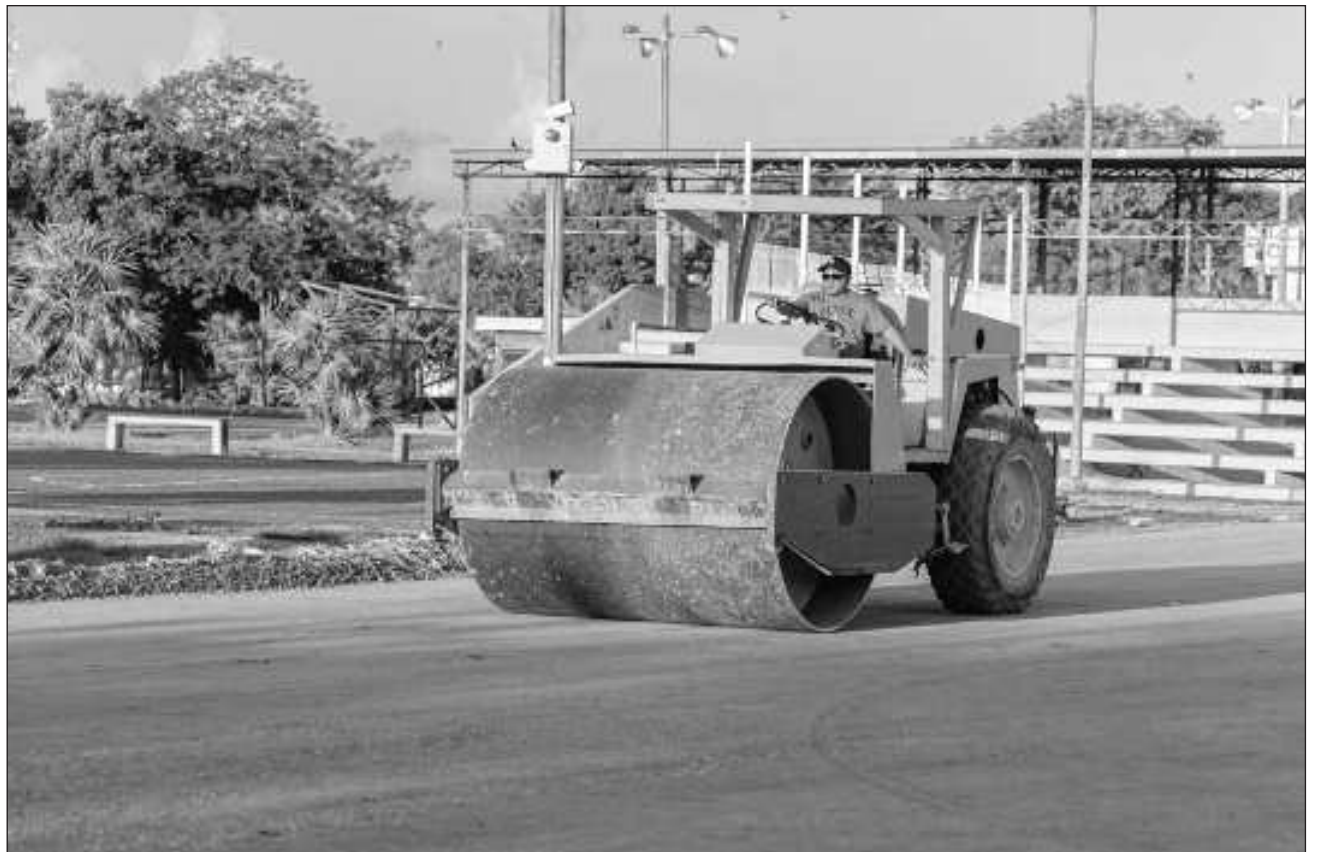
▲ La obra tendrá un impacto directo de beneficio social para 33 mil 374 habitantes. Foto ayuntamiento de Tulum
