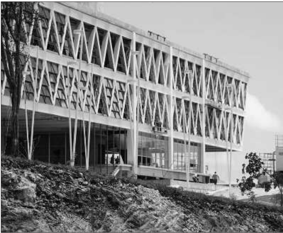
▲ Entre las cifras más altas, destacan 7 mdp bajo el concepto de suministro e instalación del sistema de aire acondicionado para el edificio 4, pero este no está en operación. Foto Fernando Eloy
