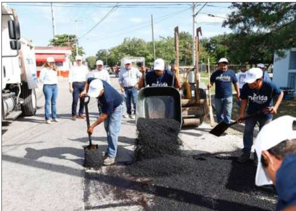
▲ Trabajadores limpiaron rejillas, pozos, áreas verdes, entre otros. Foto ayuntamiento de Mérida
