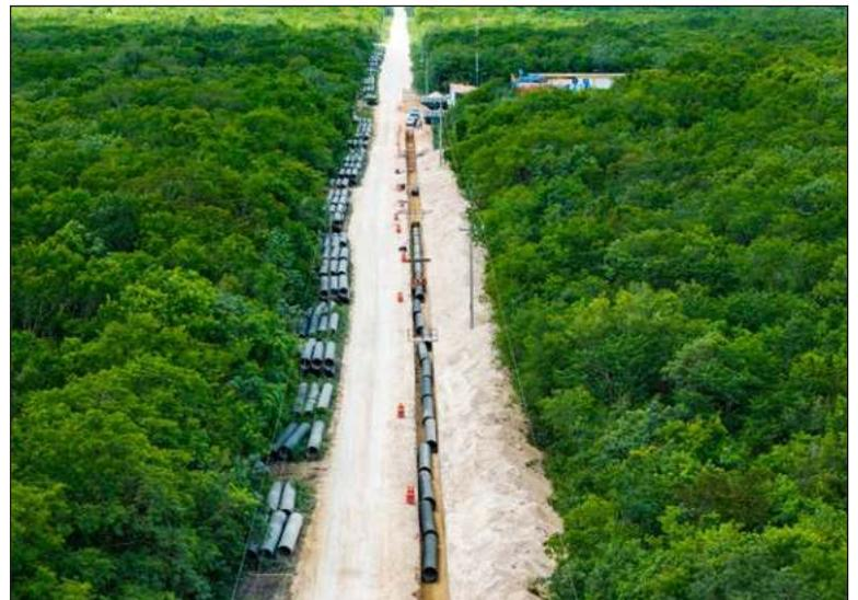
Ante el crecimiento acelerado de la población, así como el incremento en la demanda del vital líquido, este proyecto tendrá la capacidad de transportar mil 160 litros por segundo. Foto Aguakan
