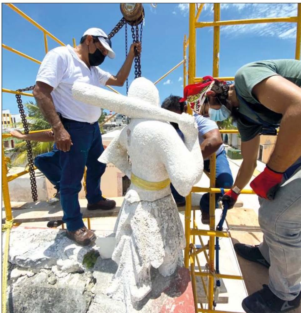
▲ Debido a la lluvia y los aerosoles marinos, la talla de piedra caliza presentaba fracturas y erosión superficial. Foto cortesía INAH Yucatán
