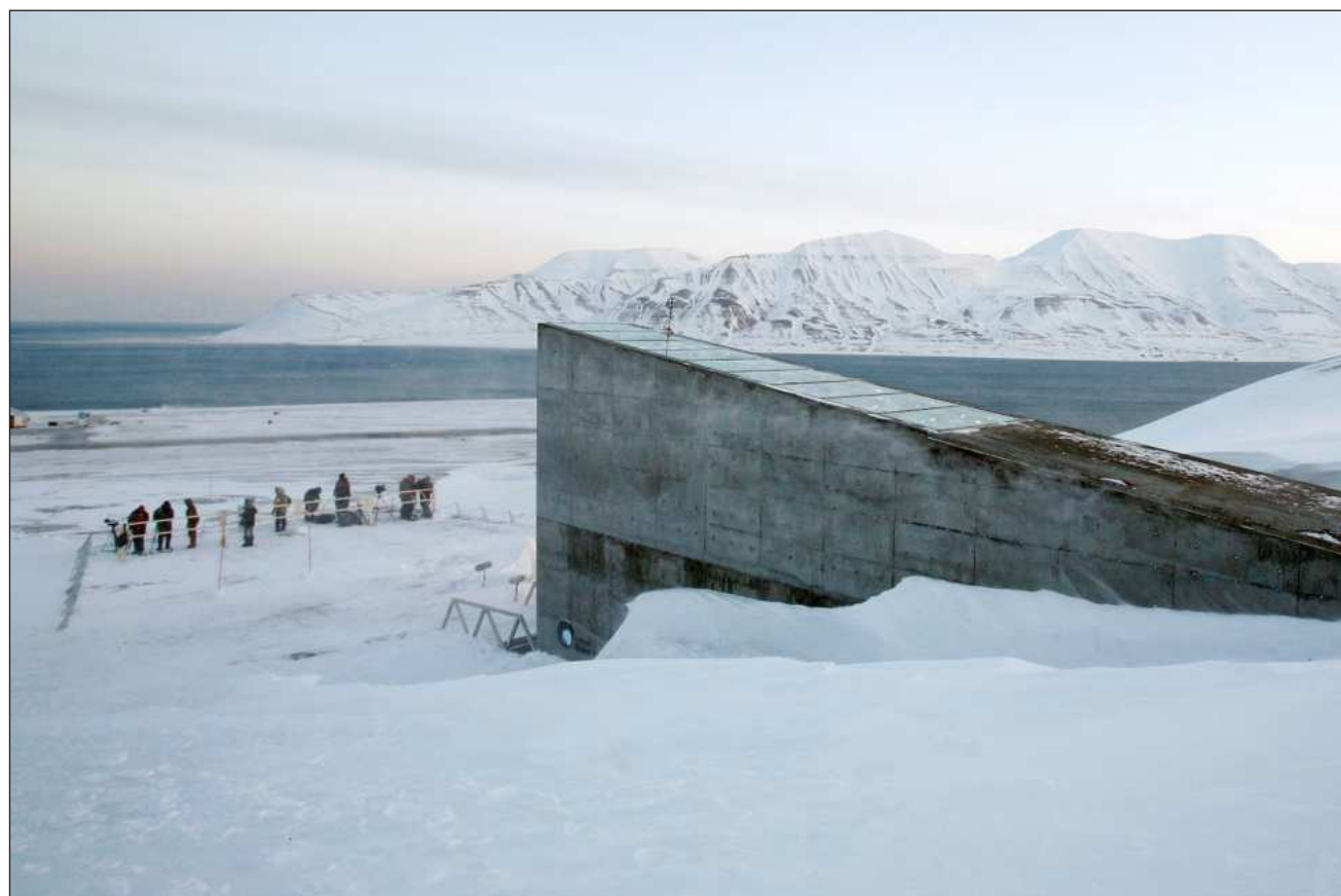
▲ Inaugurado en 2008, este almacén subterráneo fue construido por el gobierno noruego en la isla de Spitsbergen. Foto Reuters
