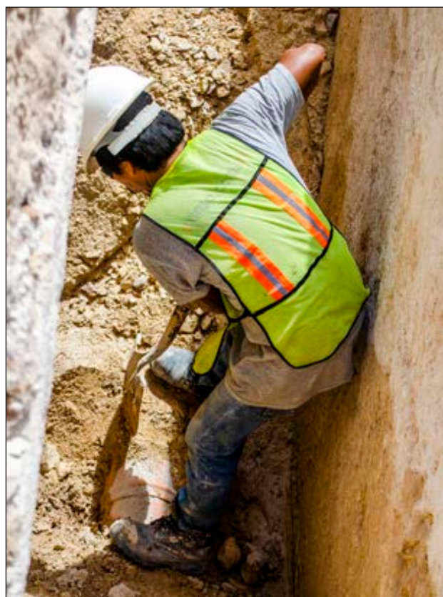
▲ La concesionaria tiene programado concluir las obras a finales de este año. Foto Aguakan
