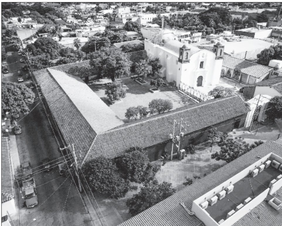
▲ La restauración del ícono cultural, fundado por el artista zapoteco Francisco Toledo en 1972, fue mediante del Programa Nacional de Reconstrucción. Foto @ccurieldeicaza
