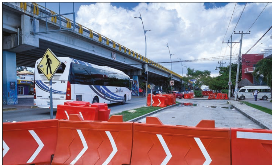
▲ El nuevo trazo será en el lado oeste de los hoteles ubicados en el tramo 5 del mega proyecto, no del lado de la playa. Foto Juan Manuel Valdivia
