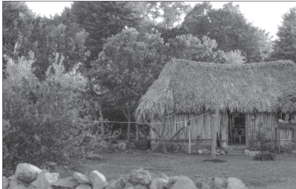
▲ La Conavi explica que con materiales deteriorados se refiere a viviendas en las que se utilizaron elementos de desecho, como lámina de cartón, carrizo, bambú, palma, barro o bajareque. Foto jusaeri
