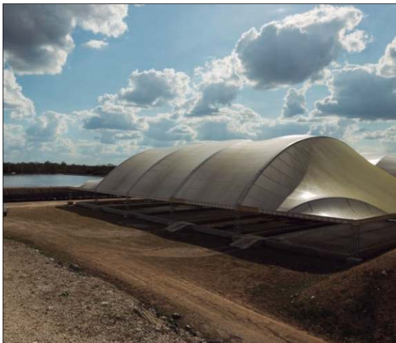
▲ “En Yucatán existen varios megaproyectos tecnológicos que sacan a relucir esta realidad, evidenciando los impactos negativos de este tipo de emprendimientos y los conflictos que ocasionan”. Foto Enrique Osorno
