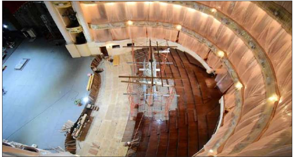
▲ Los trabajos de restauración han sido complejos y requieren de mucho cuidado. Foto Sedeculta
