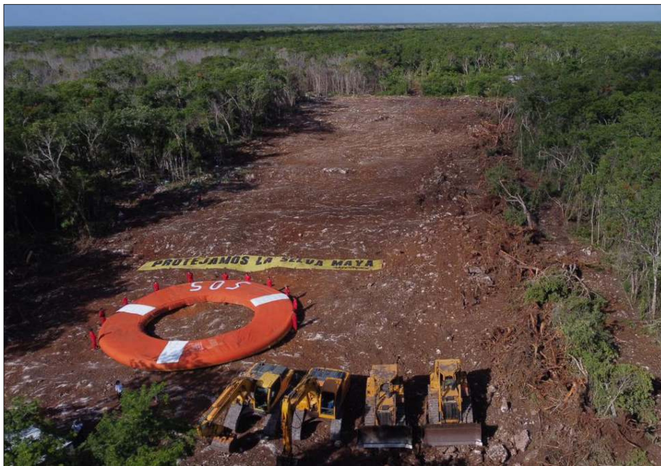
▲ En el tramo 5 del proyecto ferroviario, los activistas colocaron un salvavidas gigante con las letras SOS, haciendo alusión a la demanda de proteger la selva maya, y solicitaron al presidente Andrés Manuel López Obrador detener las obras. Foto Greenpeace
