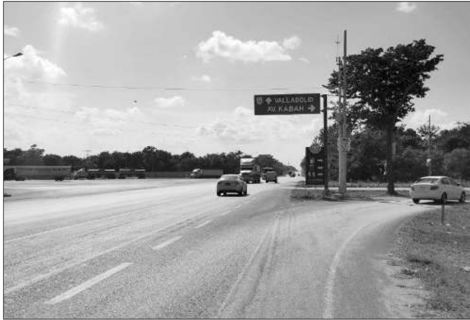
▲ Las seis vialidades permitir n el traslado vehicular de dicho bulevar hacia la avenida Huayac n, conforme el avance de los trabajos. Foto ayuntamiento de Benito Ju rez
