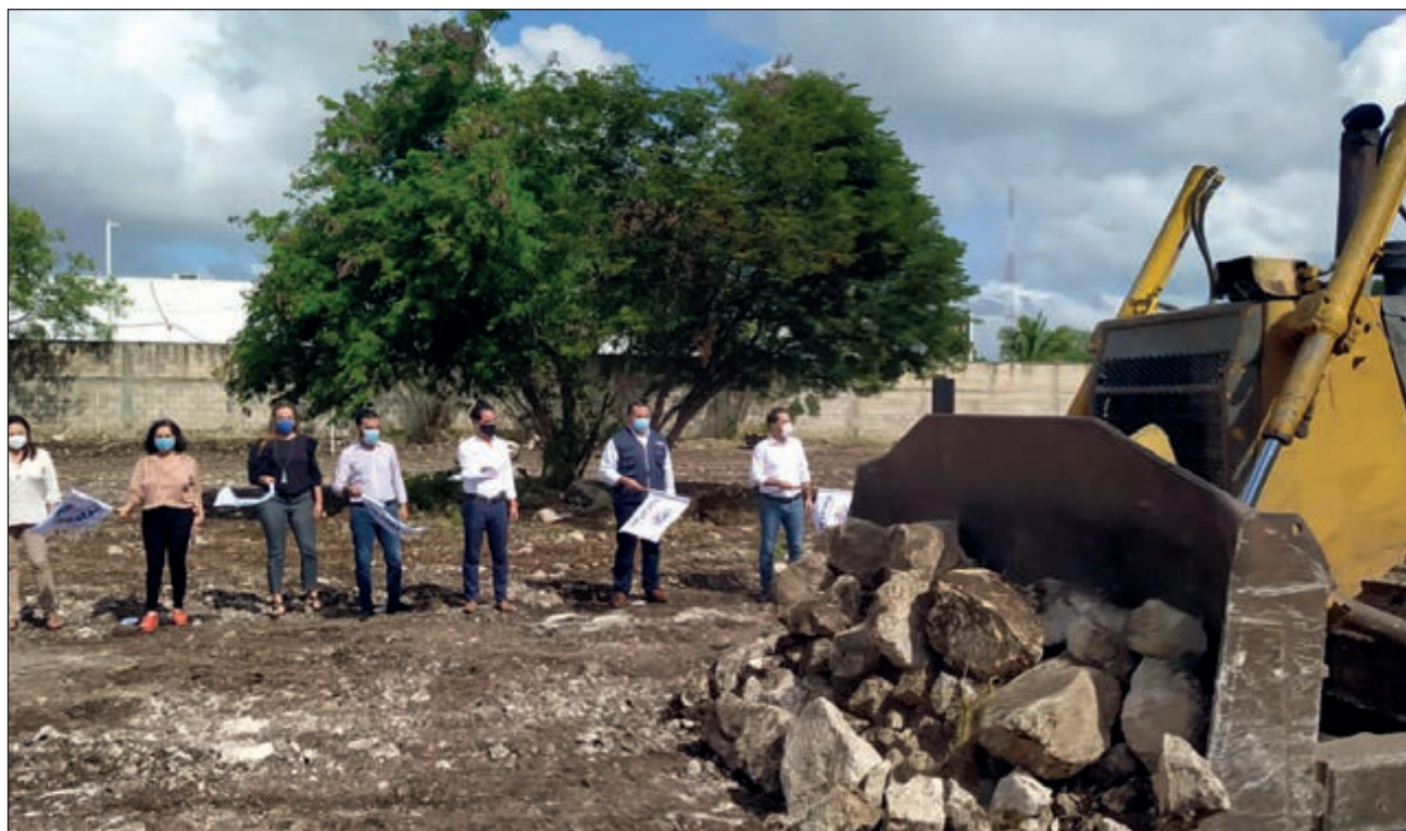
▲ Los trabajos contribuirán a mejorar la conectividad en la zona norponiente de la capital yucateca. Foto gobierno de Yucatán
