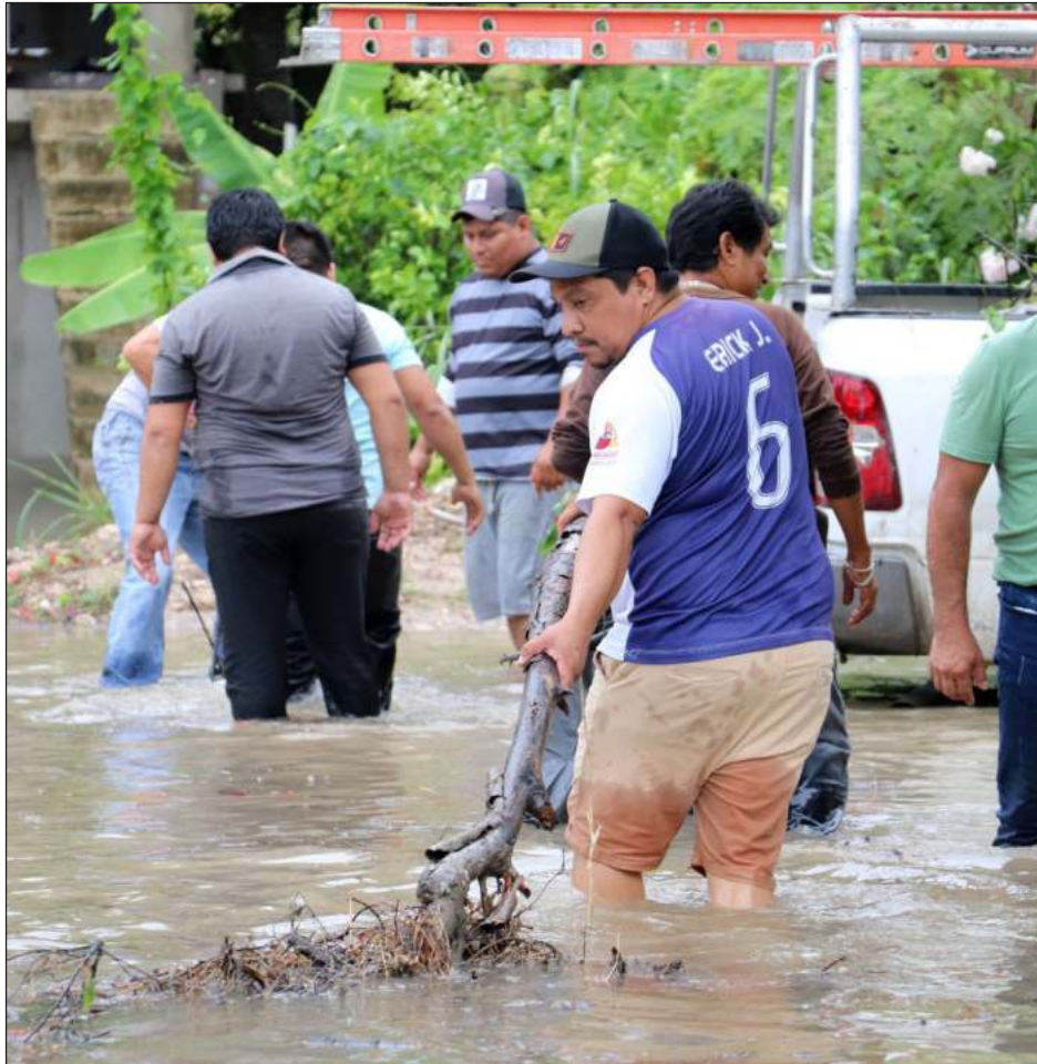
▲ Personal de Bomberos, Protección Civil, Servicios Públicos y otras áreas municipales, trabajan de manera coordinada en la limpieza de calles y alcantarillas. Foto ayuntamiento de Bacalar
