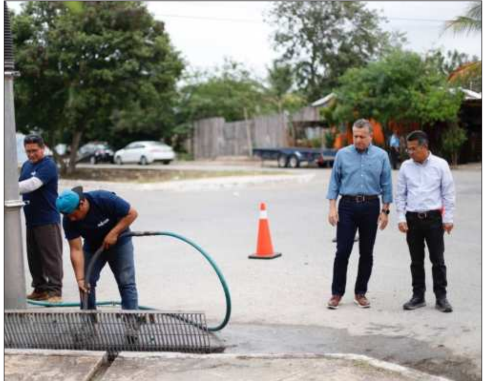
▲ José Collado, director de Servicios Públicos, dijo que adicional a la reconstrucción del parque, limpiaron el sitio y se incluyó el desazolve de zanjas pluviales. Foto ayuntamiento de Mérida
