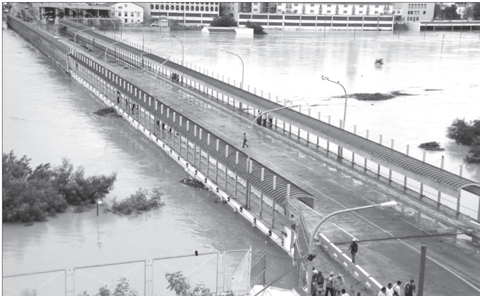
▲ La distribución de las aguas fronterizas entre México y Estados Unidos está regulada mediante un añejo tratado internacional. En la imagen, Puente sobre el río Bravo, en Nuevo Laredo, Tamaulipas. Foto Cuartoscuro
