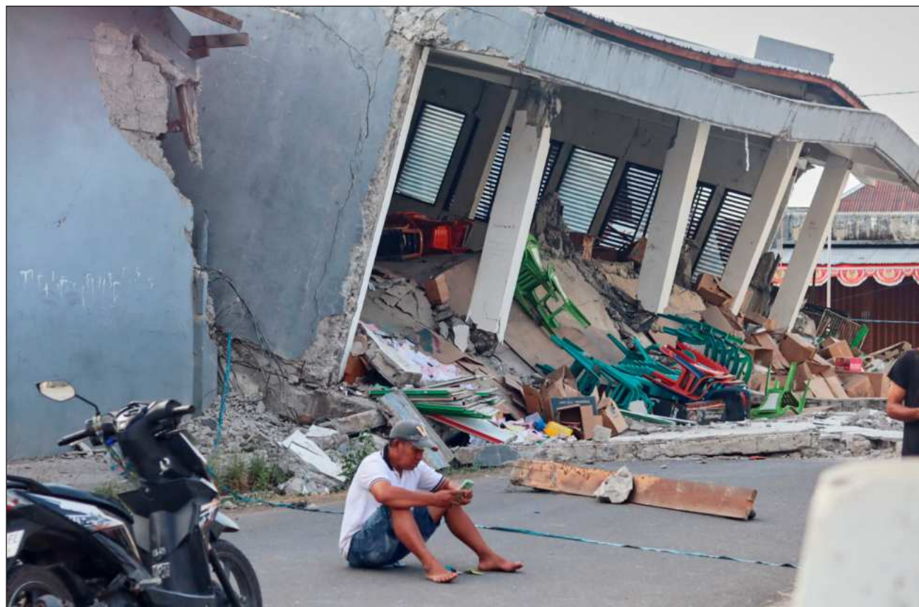
▲ Numerosas personas se quedaron sin electricidad ni telecomunicaciones, y al menos una ruta de acceso estaba inaccesible. Foto Ap
