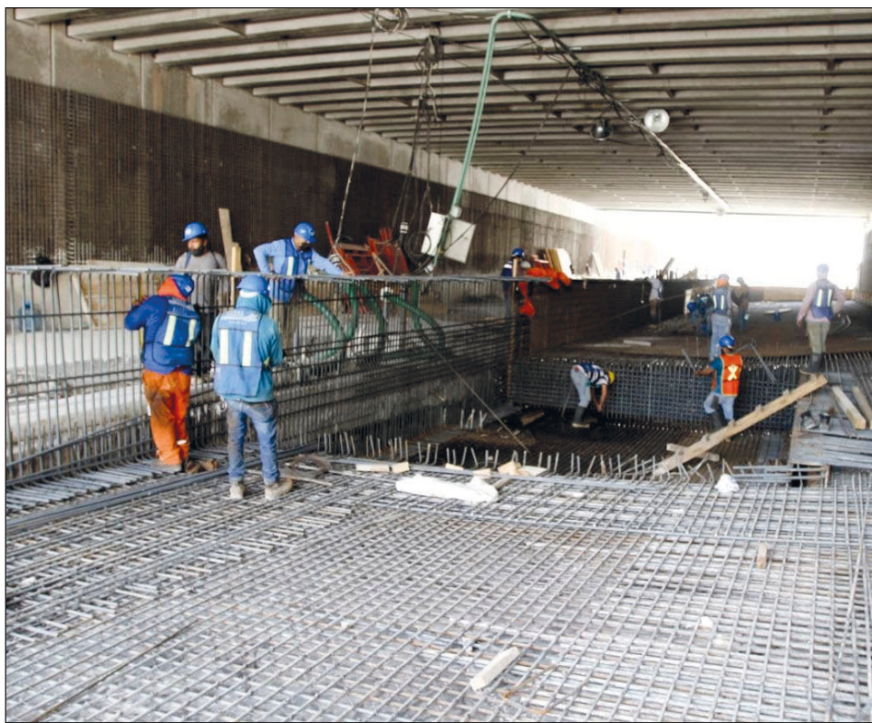
▲ Pese a las recientes lluvias, el manto freático ha mantenido su nivel, permitiendo el avance de los trabajos. Foto ayuntamiento de Mérida
