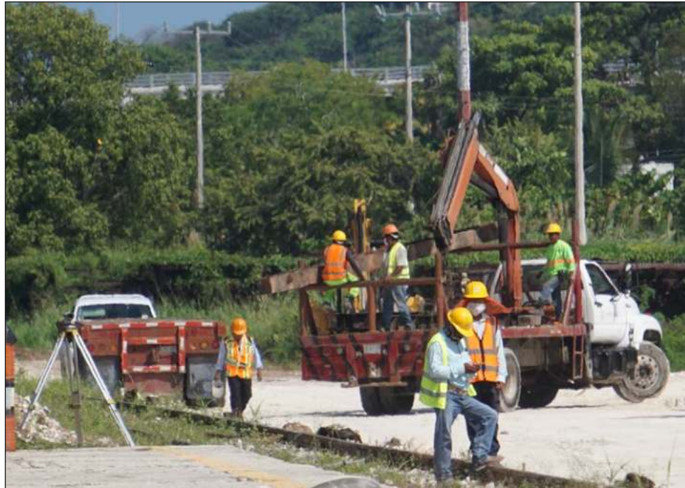
▲ Existen amparos vigentes que prohíben cualquier trabajo de construcción nuevo que no sean las vías férreas ya existentes antes del proyecto. Foto Fernando Eloy
