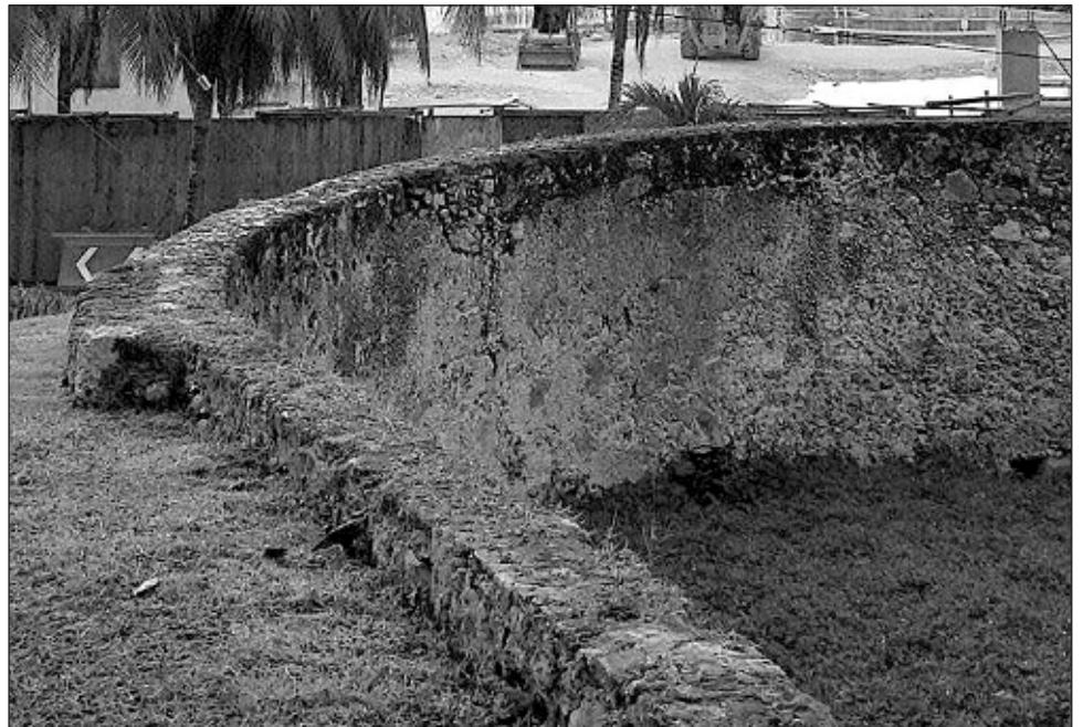
▲ Las obras a orillas de la laguna son una ampliación de las instalaciones de la Secretaría de la Defensa ya existentes en Bacalar y corresponden a un centro de retiro para elementos militares. Foto Consejo Ciudadano y Científico Pro Restauración y Preservación de Bacalar
