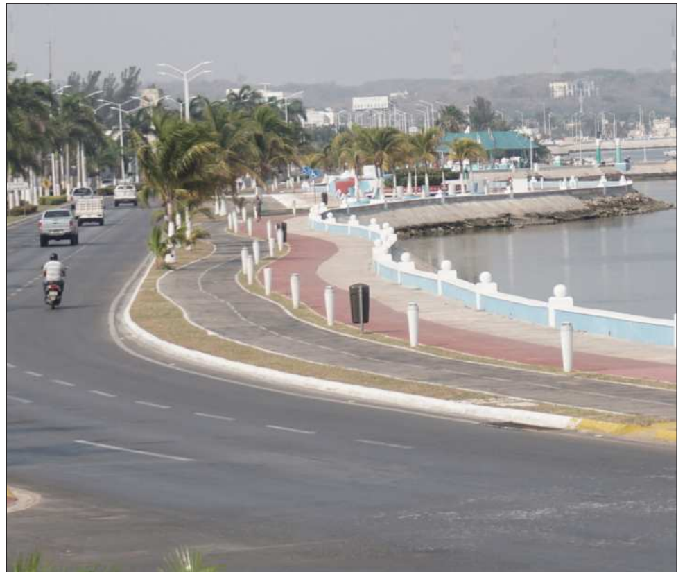
▲ Contemplan 5 mil 400 metros lineales de señalamiento vial, 50 metros cúbicos de nivelación de carpeta asfáltica e instalación de 543 bolardos con base de concreto. Foto Fernando Eloy / Archivo
